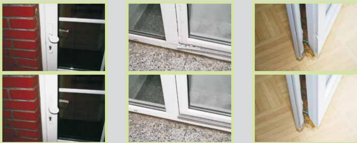
Beschädigungen an Tür- und Fensterelementen aus Kunststoff werden durch Wärmezufuhr mit einem PVC-Schweißgerät und mit speziellen Werkzeugen annähernd in ihre Ursprungsform gebracht.
