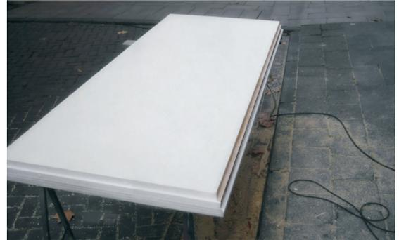
Bei einer Instandsetzung einer der Art schwer beschädigten Tür aus Holz müssen die schadhaften Stellen mit einem speziellen Fräsverfahren entfernt werden. Dort wird dann Neuholz gleicher Art und Maserung eingepasst und dauerhaft verleimt. Wenn die neuen Nuten und Schloßtaschen für die Aufnahme der Verriegelung gefräst sind, kann die Oberfläche erneuert werden. Dazu wird die originale Oberfläche aus der MDF-Platte mit der RESOPAL-Beschichtung aufgebracht.
