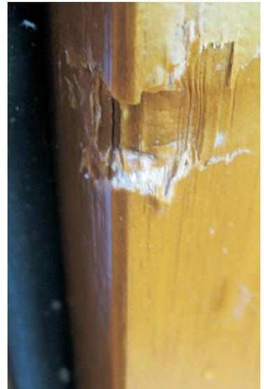
Durch einen Einbruch wurde ein mehrteiliges Fensterelement aus Holz stark beschädigt. Rahmen und Fensterflügel weisen durch massive Gewalteinwirkung an mehreren Stellen Schäden auf.
