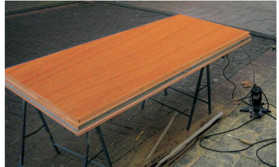
Bei einer Instandsetzung einer der Art schwer beschädigten Tür aus Holz müssen die schadhaften Stellen mit einem speziellen Fräsverfahren entfernt werden. Dort wird dann Neuholz gleicher Art und Maserung eingepasst und dauerhaft verleimt. Wenn die neuen Nuten und Schloßtaschen für die Aufnahme der Verriegelung gefräst sind, kann die Oberfläche erneuert werden. Dazu wird die originale Oberfläche aus der MDF-Platte mit der RESOPAL-Beschichtung, in diesem Fall ist es ein Holzdekor, aufgebracht.
