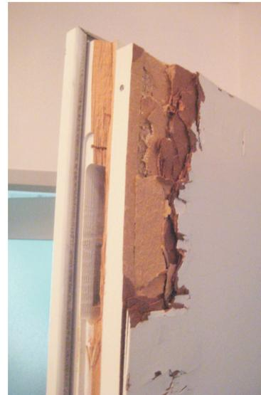
Durch einen Einbruch wurde eine Büroeingangstür aus Holz mit einer Stahlzarge zum Teil stark beschädigt.
