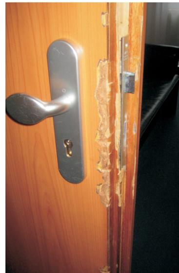
Durch einen Einbruch wurde eine Büroeingangstür aus Holz mit einer Stahlumfassungszarge stark beschädigt.
