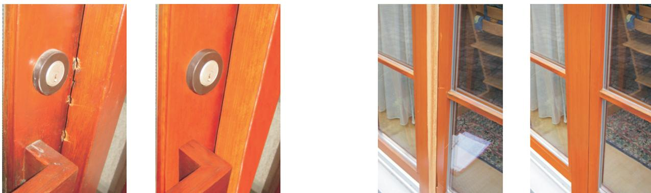
Bei schweren Beschädigungen an Türen und Fenstern aus Holz wird die schadhafte Stelle mit einem speziellen Fräsverfahren entfernt. Dies wird durchgehend längs am betroffenen Profil ausgeführt.
