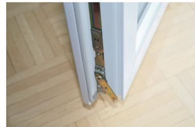
Beschädigungen an Tür- und Fensterelementen aus Kunststoff werden durch Wärmezufuhr mit einem PVC-Heißluftgerät und mit speziellen Werkzeugen annähernd in ihre Ursprungsform gebracht. Kleinere Unebenheiten werden mit Kunststoffersatz aufgefüllt und verschliffen.
